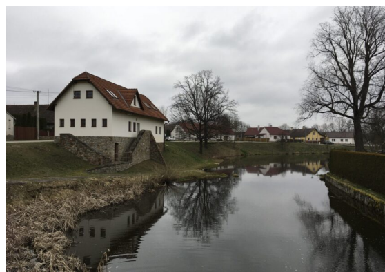
Společenský objekt na návsi umístěný nad vodní nádrží
